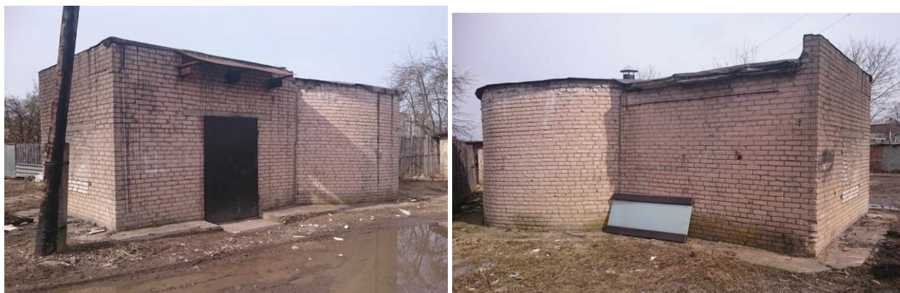
Фото 12, 12.1. Здание КНС «Береговая»
