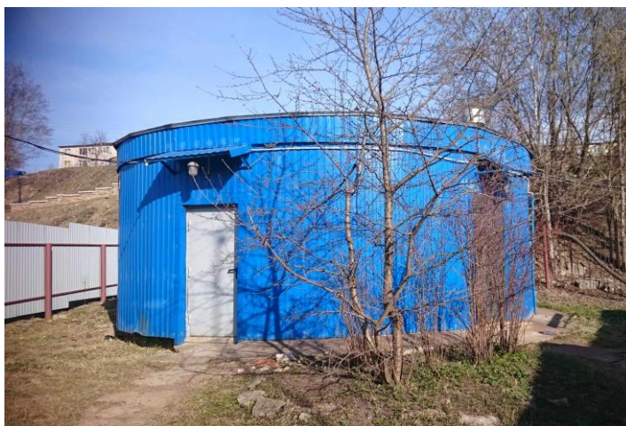
Фото 13. Здание КНС «Псковская»
