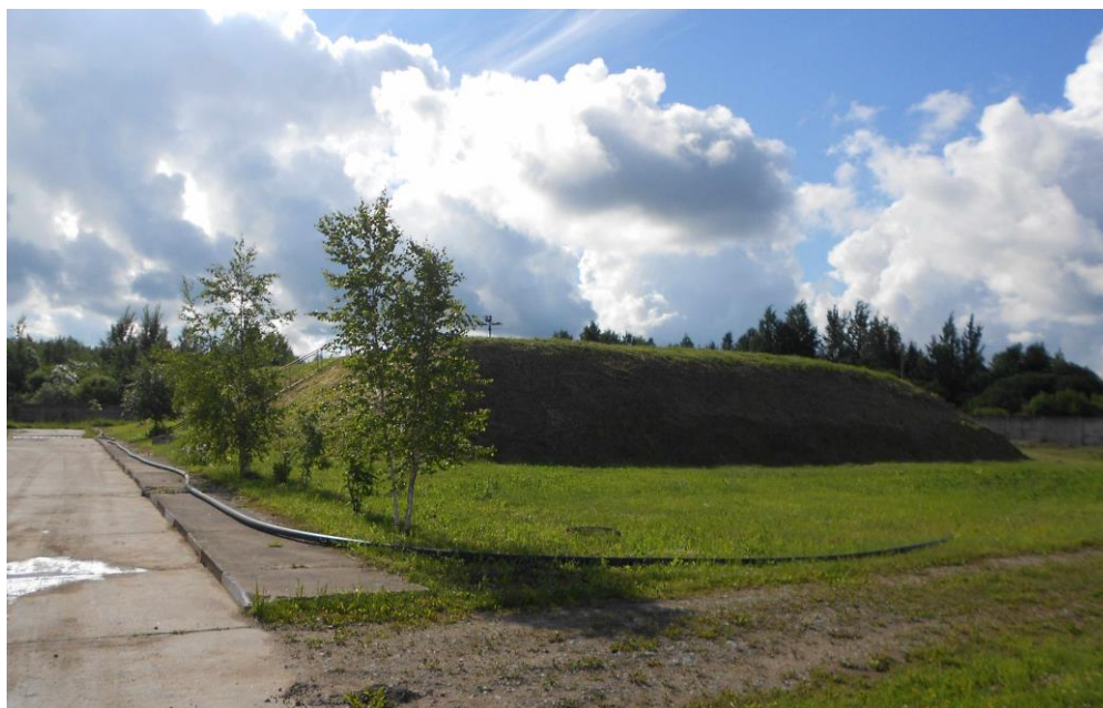
Фото 4. Резервуары чистой воды
