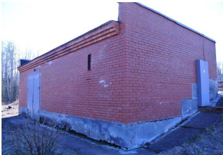
Фото 10. Здание иловой насосной станции
