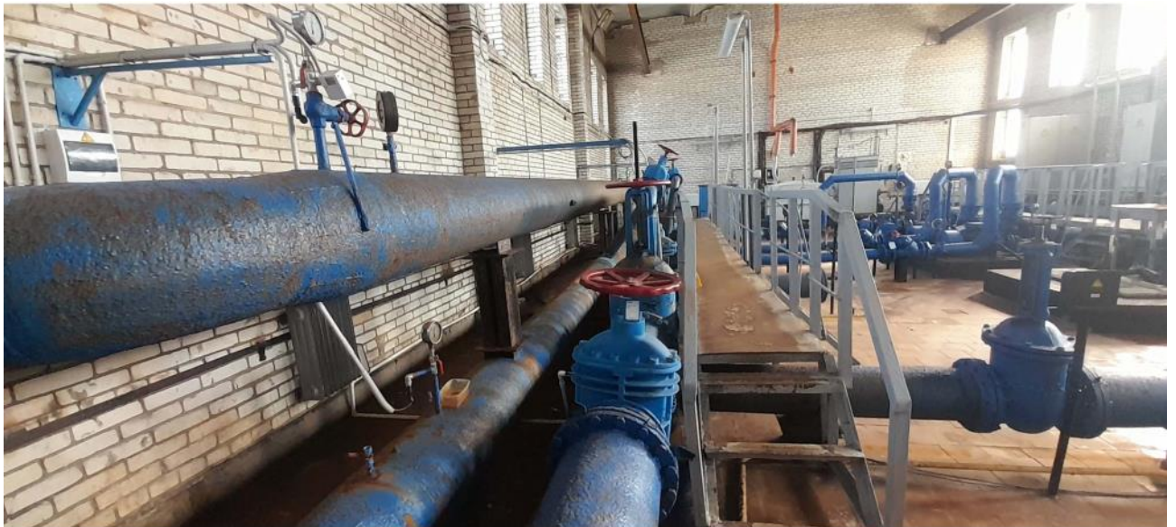
Фото 2, 2.1, 2.2. Насосная станция второго подъема
