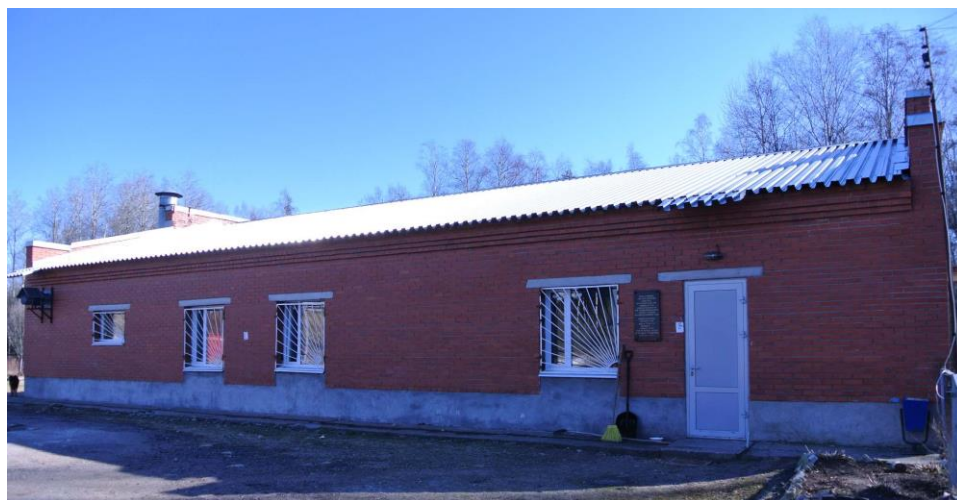
Фото 9. Здание административно-бытового корпуса
