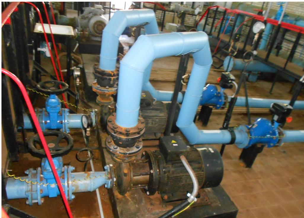
Рис. 6. Сетевые насосы Grundfos
