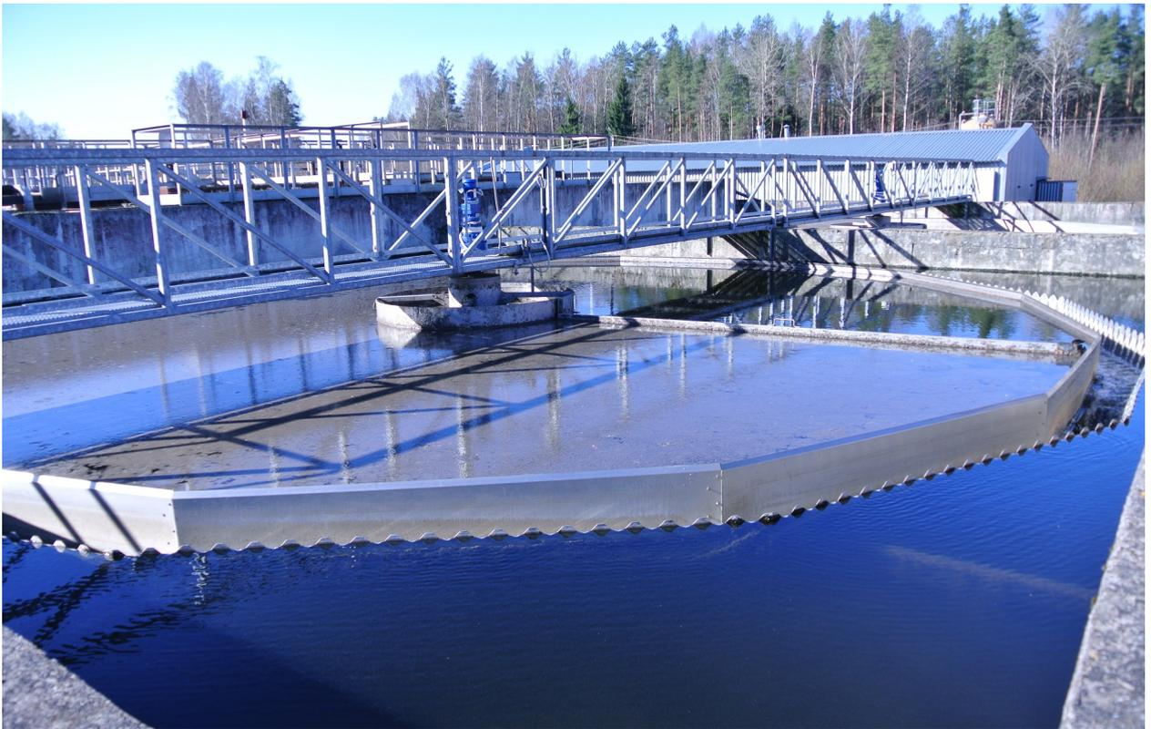
Рис.6. Вторичные отстойники радиального типа, оснащенные илоскребами
